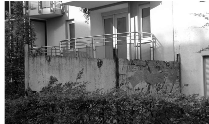
Stück der Hinterlandmauer, das heute als Gartenmauer dient, Kieler Straße Piece of the rear wall now used as a garden wall, Kieler Strasse
