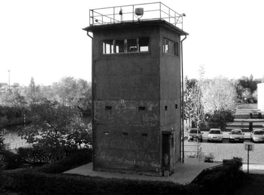
Beobachtungs- und Führungsturm der Grenztruppen, Kieler Straße Border troops observation and tower with command post, Kieler Strasse
