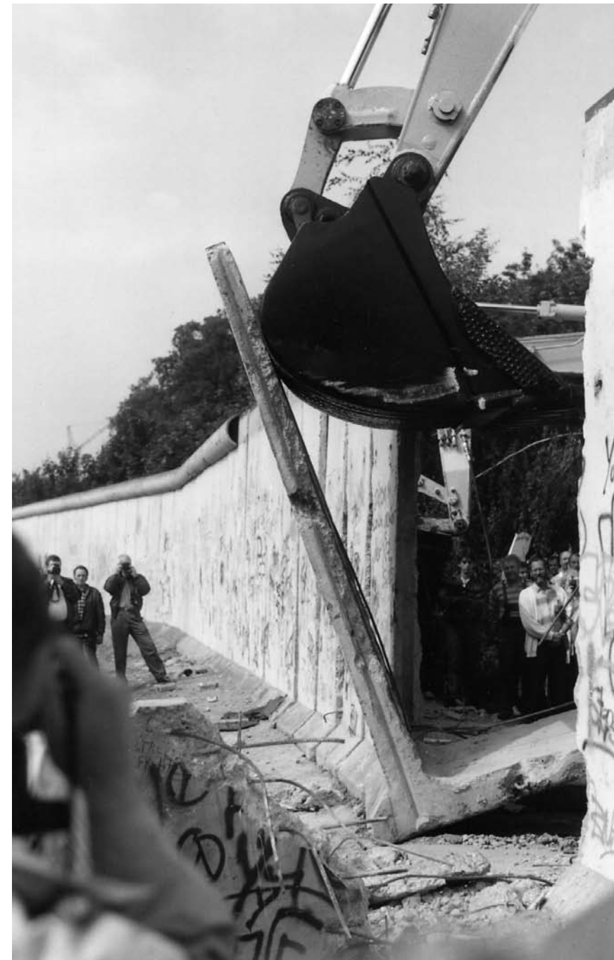
Beginn des offiziellen Abrisses der Mauer an der Bernauer Straße/ Ackerstraße, 13. Juni 1990 Official demolition of the Berlin Wall, starting at the corner of Bernauer Strasse and Ackerstrasse, June 13, 1990
